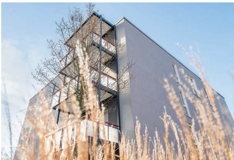
VIVAWEST investiert rund 72 Millionen Euro in die Modernisierung des Quartiers
